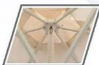
δάκτυλη κατασκευή από προφίλ αλουμινίου διαστάσεων 30x16x1,5mm
